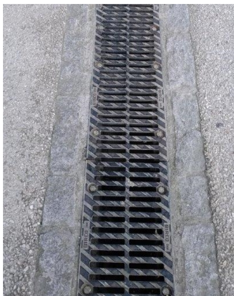
Caniveau avec un motif « fente longitudinale » et verrouillée par quatre boulons
