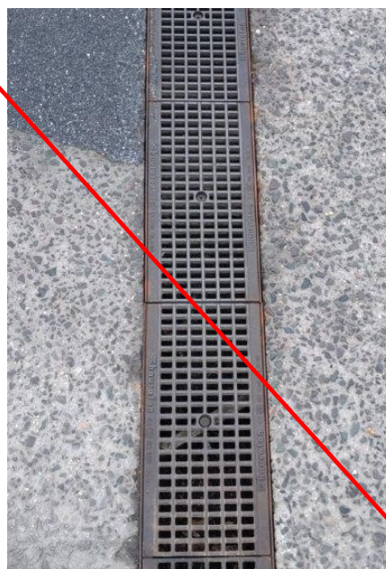
Caniveau avec un motif caillebotis et un mécanisme de verrouillage à barres
