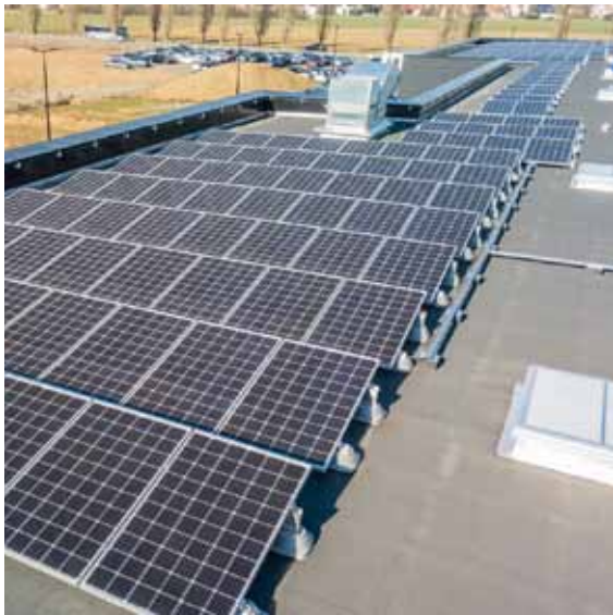
Exemple de toiture avec panneaux photovoltaïques - Rey de Crécy Architectes, Mulhouse
